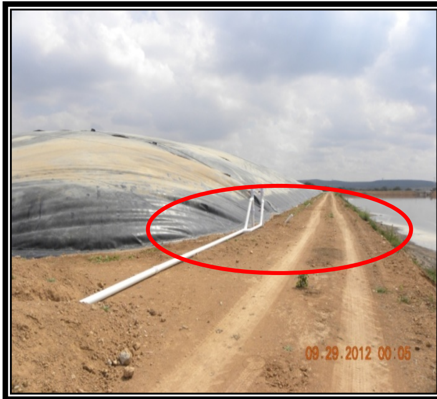
Taludes erosionados
